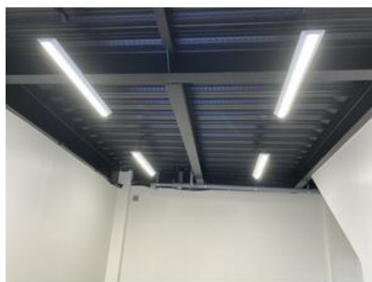
鉄骨は外観に合わせてブラックに塗装
